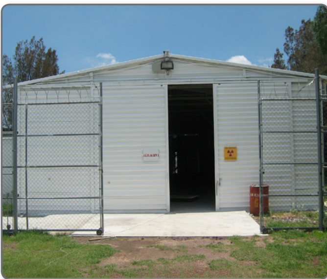
Figura 1. Almacén I del Centro de Almacenamiento de Desechos Radiactivos
